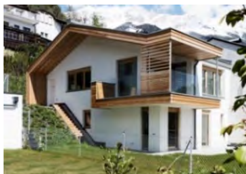
Wohnhaus Schießstandgasse, Innsbruck
