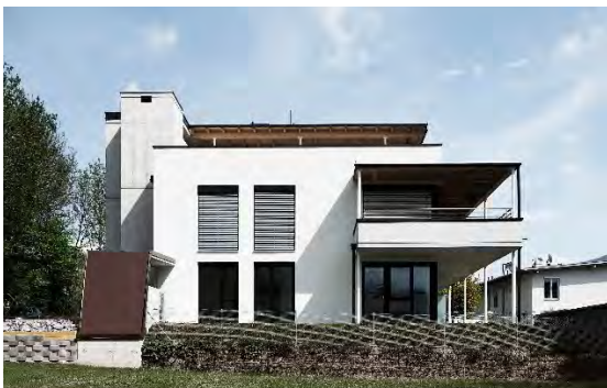
Wohnanlage Dörfer Straße, Absam
