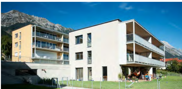
Wohnanlage Canisiusweg, Rum
